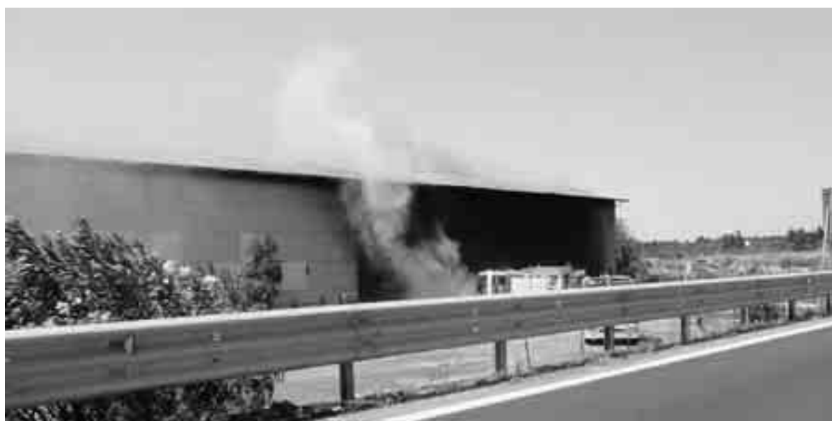
Una veduta parziale dell'edificio che accoglie gli impianti dell'ex Alba sud, le cui fibre di amianto si stanno sbriciolando a causa degli agenti atmosferici. Il fenomeno, segnalato dal «Coordinamento per lo sviluppo sostenibile», rischia di innescare un'autentica bomba ecologica.
